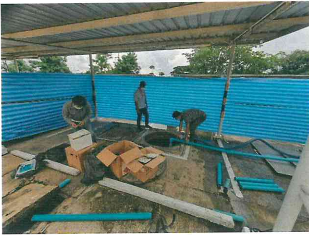
รูปที่ 46 โครงการกำหนดให้มีการล้างทำความสะอาด และตรวจสอบอุปกรณ์ในถังประปาใต้ดิน ทุก 6 เดือน
