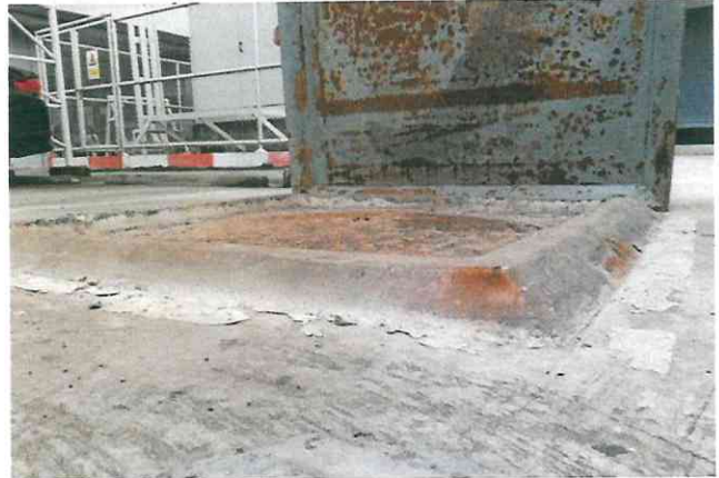
รูปที่ 48 ฝาดังเก็บน้ำของโครงการมีขอบยาง และอยู่สูงกว่าระดับพื้นผิวที่จอดรถ เพื่อป้องกันการปนเปื้อนลงสู่ถังเก็บน้ำ
